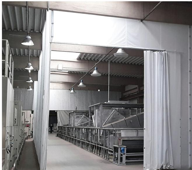
Flexiscreen ist eine **temporäre, raumhohe Schutzplane**, die **zur Staubeindämmung** während Bau- und Sanierungsprojekten, sowie Installations- und Ausbaumaßnahmen in Fabriks- und Lagerhallen eingesetzt wird.
